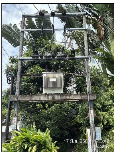
รูปภาพที่ 2.11 หม้อแปลงไฟฟ้า
